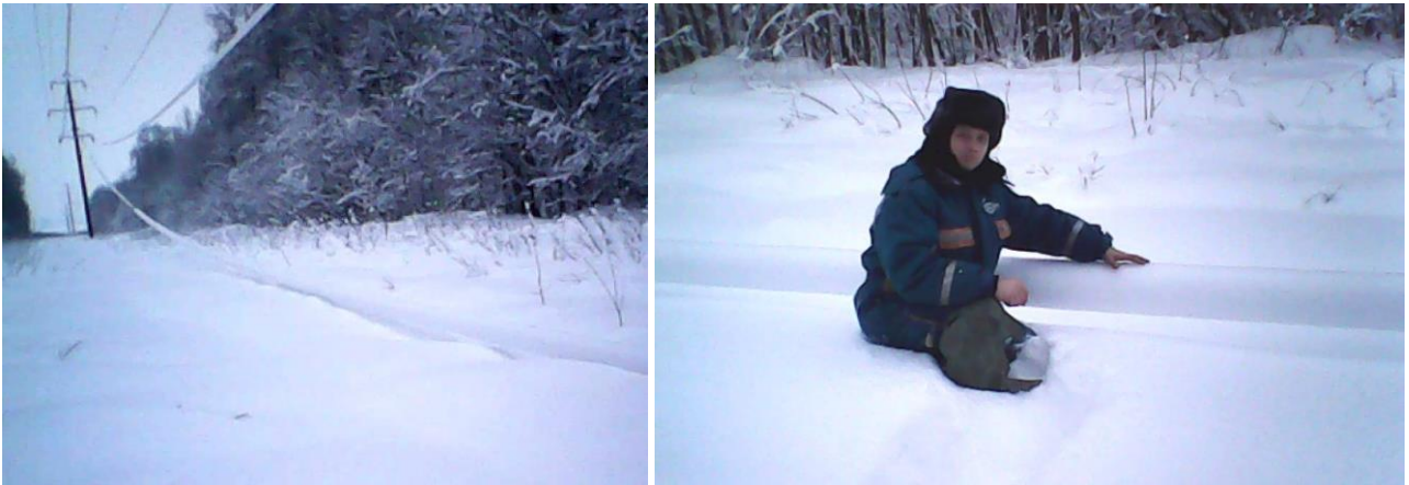
Рис. 5. ВОК лёг на землю под тяжестью гололёда.
