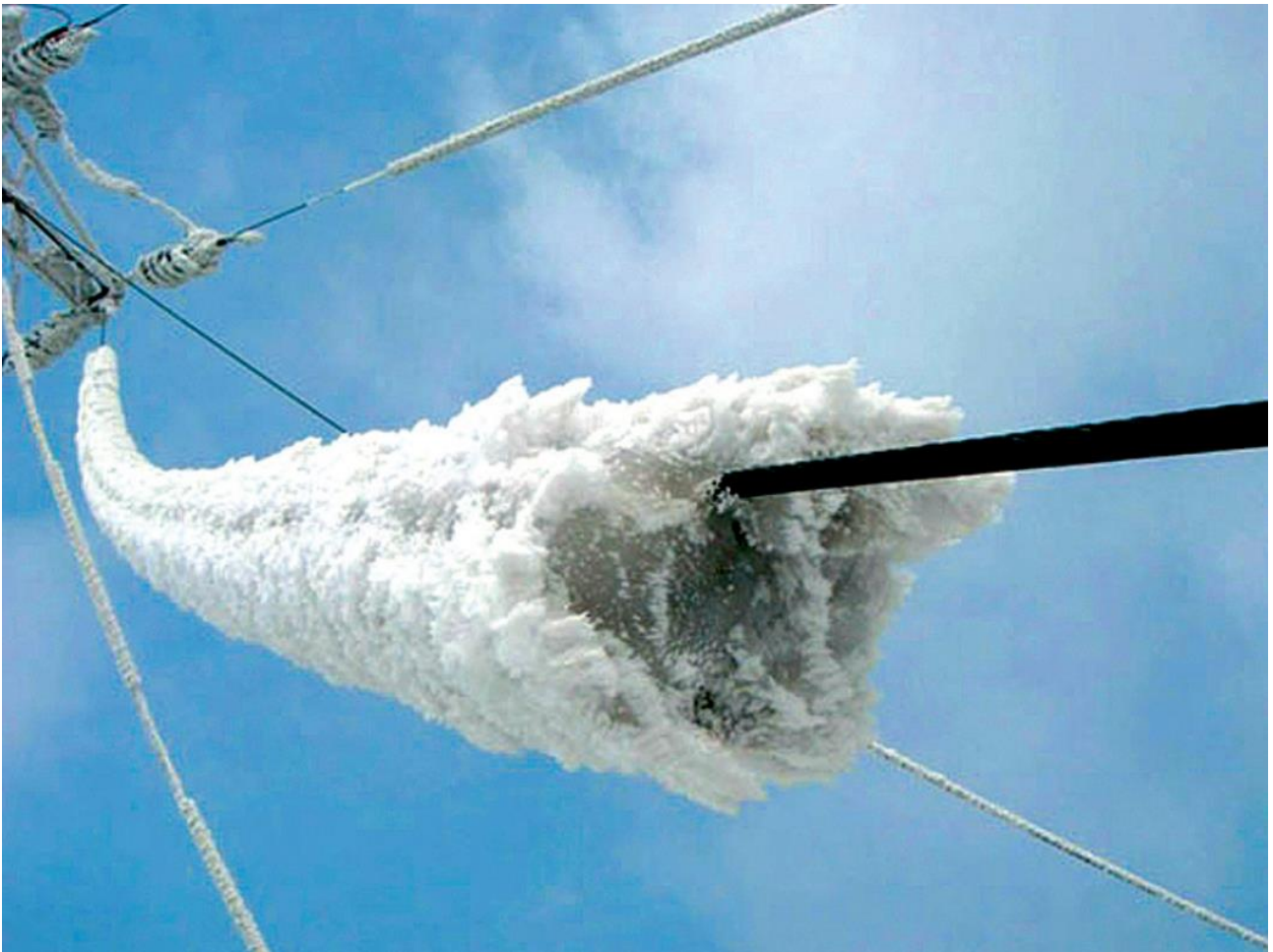
Рис. 4. Гололёдно-изморозевые отложения на элементах ВЛЭП.
